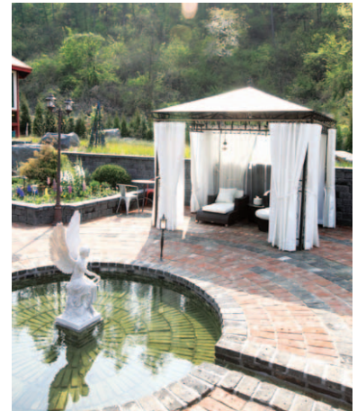
물은 2차 원형 연못에 머물다 수로로 흐른다. 연못 벽돌은 줄눈을 덜 채워 입체감을 줬다.
