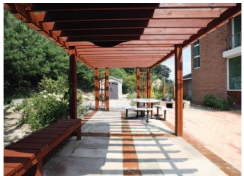
After | 비닐하우스를 철거하고 동선과 공간을 나눈 후, 길을 만들었다. 사용하지 않는 물탱크와 짬뽕방 전해를 제거하고 좌측 창고는 이전 배치했다.
