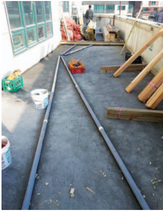
공사 전 쓸모없이 버려졌던 테라스 공간
